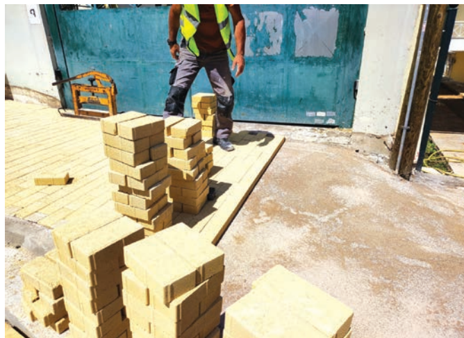
Τοποθέτηση κυβόλιθων στην οδό Πέτρουλα
